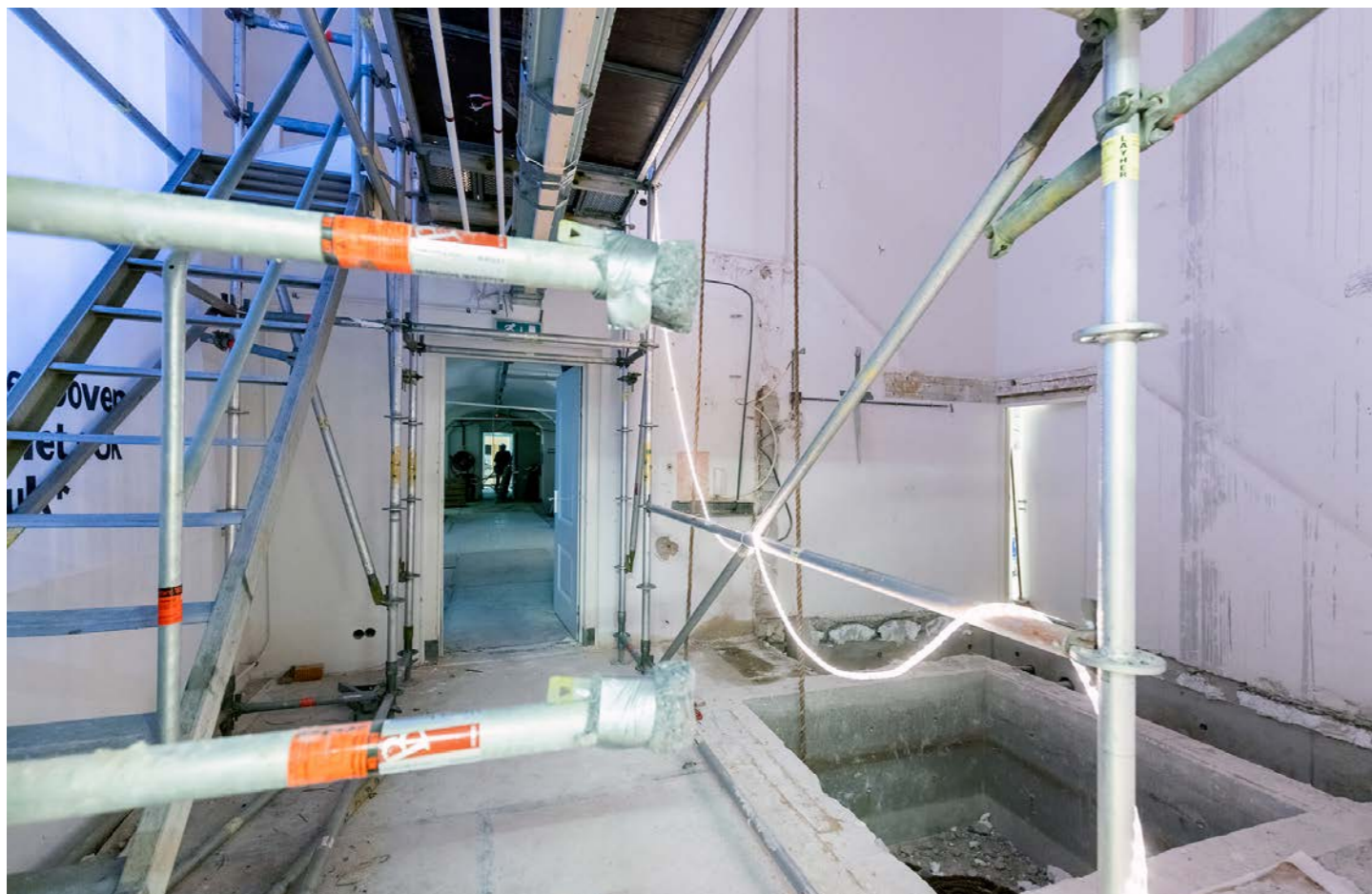
Werkzaamheden aan de nieuwe trappenhuizen en ruimere lift. Fotografie: Aad Hoogendoorn
