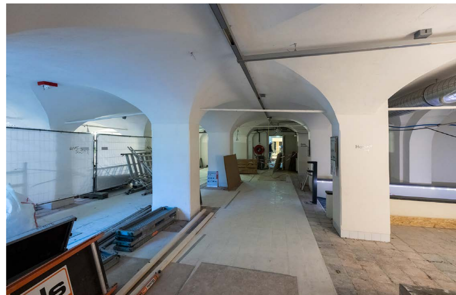
Werkzaamheden in het souterrain. Fotografie: Aad Hoogendoorn
